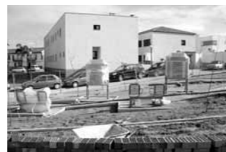
Finaliza la colocación del mobiliario y la jardinería en el Nuevo Parque.
