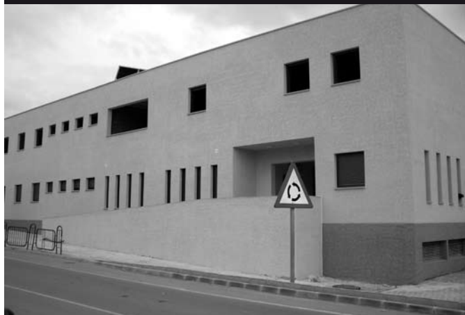
▲ Terminadas las obras de la primera planta de la unidad de estancia diurna, pertenecientes al Plan E 2009.
