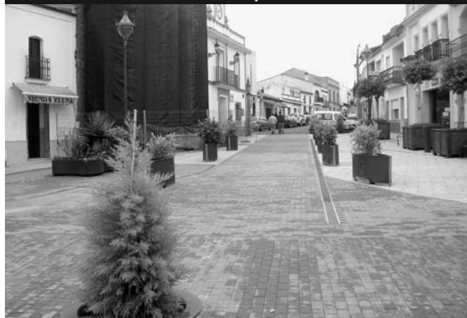
▲ La nueva zona de rodadura de la Plaza de España permanecerá abierta al tráfico en los días laborables.
