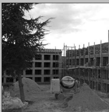
Construcción de 72 nichos
