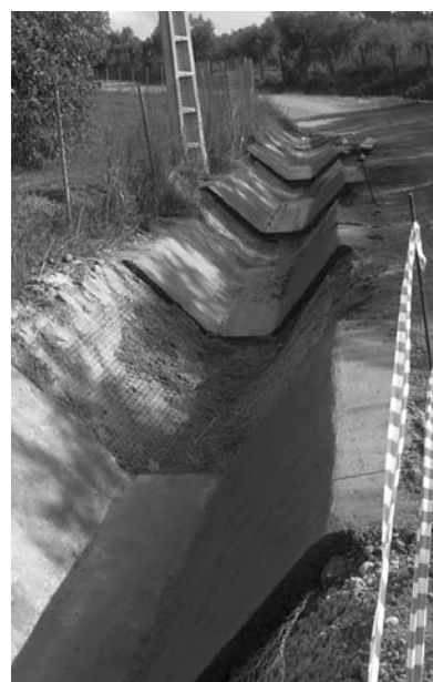
Eliminación de sedimentos en avenida de La Amistad.
